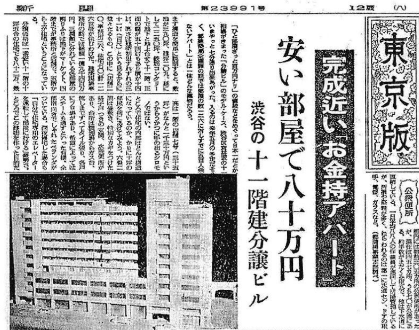
図1 分譲マンション1号の宮益坂ビルディング
